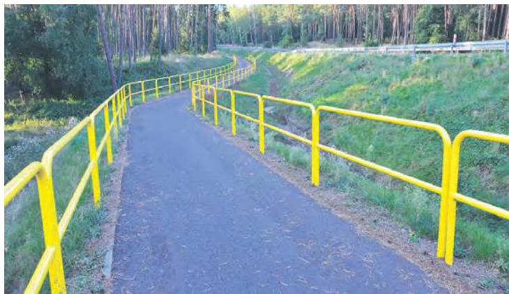
– 64-letnia kobieta, mieszkanka Tucholi w trakcie jazdy rowerem zahaczyła o barierki zamontowane w tym miejscu wzdłuż ścieżki rowerowej – wyjaśnia okoliczności fatalnego wypadku prokurator Marcin Przytarski.
