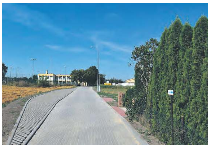
Ul. Pocztowa w Pruszczu.
