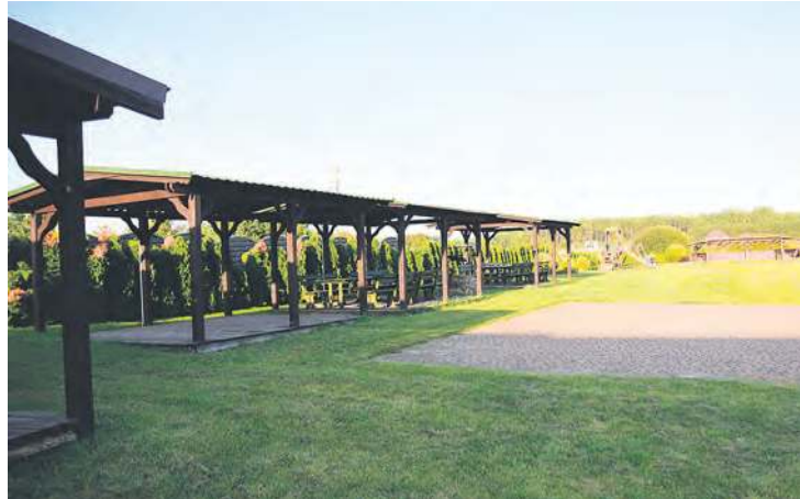
Mieszkańcy sołectwa Laski przeznaczą 12.661,10 zł na wymianę poszycia dachowego nad zadaszeniami na placu sołeckim.
