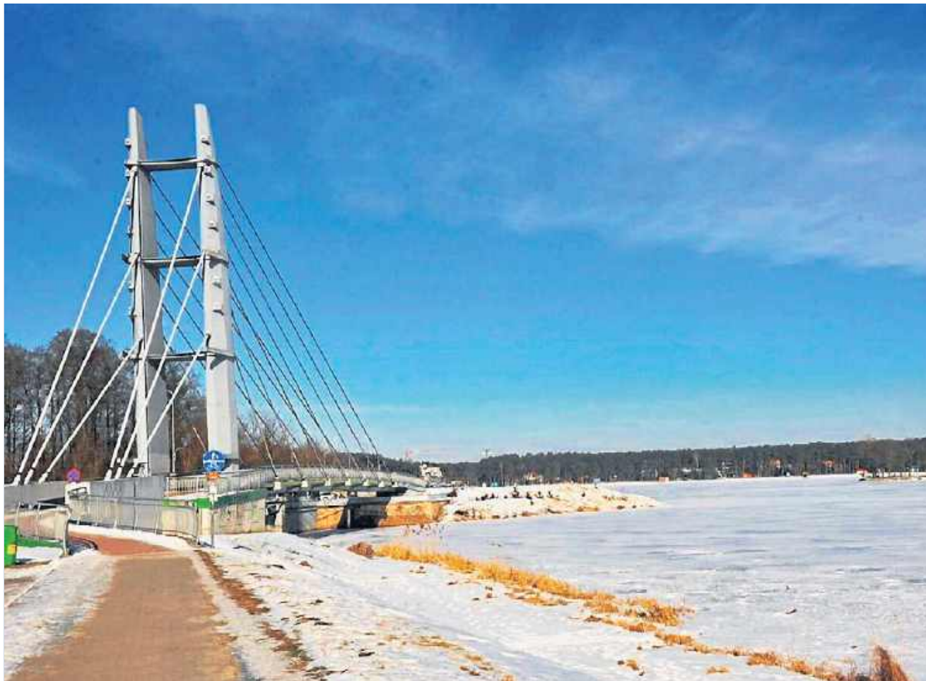
Duża część budżetu z Funduszu Szwajcarskiego przeznaczona będzie na inwestycje w Sielpi.
