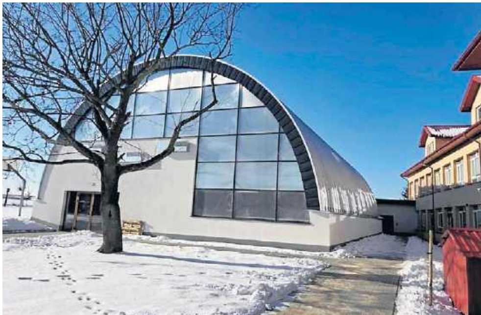
Tak prezentuje się nowa hala sportowa zbudowana przy Publicznej Szkole Podstawowej imienia Marii Konopnickiej w Kłudnia, na terenie gminy Klwów.
