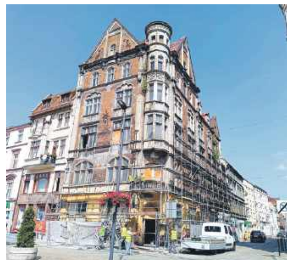
Jeśli będzie sprzyjająca aura, to zabytkowa kamienica na Rynku będzie wyremontowana jeszcze w tym roku
