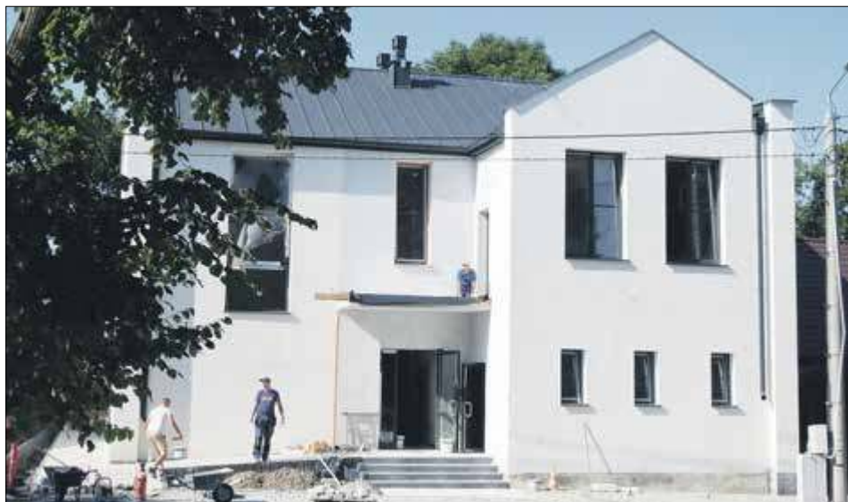
W budynku socjalno-komercyjnym w centrum Wisznice powstaną mieszkania treningowe, gabinety rehabilitacyjne oraz zabiegowe. W drugiej części mała sala kinowa dla mieszkańców
