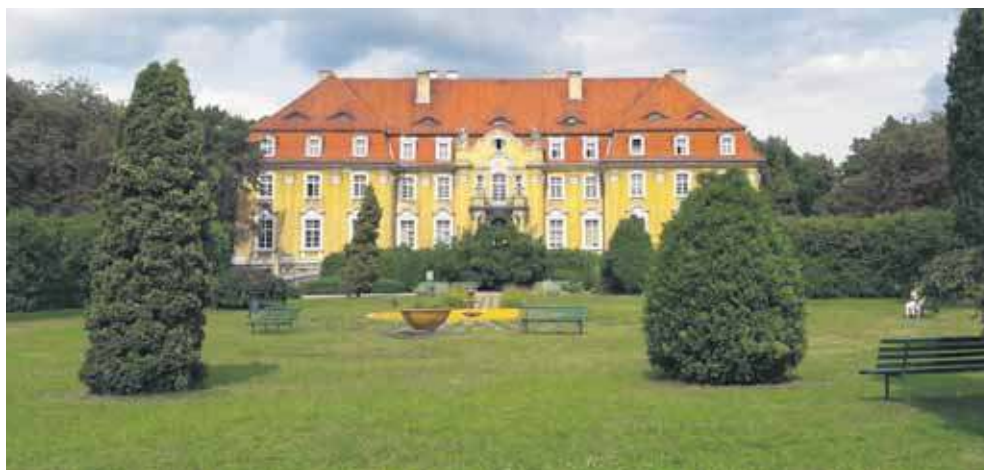
Pałac Ballestremów w Kochanicach. Obecnie mieści się w nim oddział rehabilitacyjny szpitala urazowego w Piekarach Śląskich. Pałac otoczony jest zabytkowym parkiem z pomnikowymi drzewami
