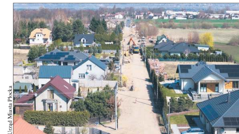
Trwa przebudowa ulicy Browarnej
