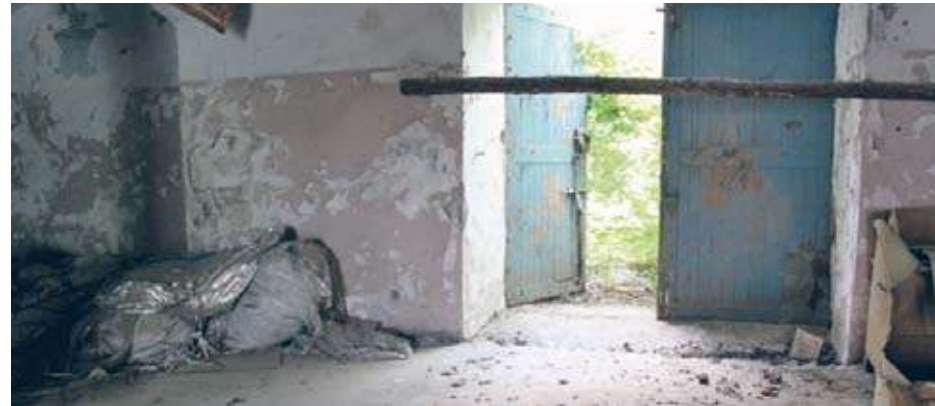
Warto przyjść m.in. po to, by odwiedzić sam budynek. Następna okazja będzie najpewniej dopiero we wrześniu 2023 r. – wtedy ma zostać oddany do użytku po remoncie
