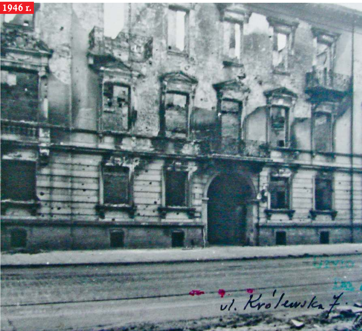
Spalona kamienica przy ul. Królewskiej 7, zburzona w 1946 r. | fot. Archiwum BOS, repr. Janusz Sujewski/Gazeta Polska
