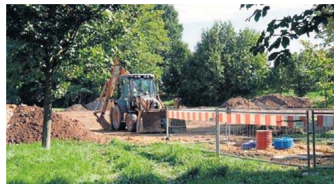
Roboty będą prowadzone etapami, więc jest szansa, że dzieci będą mogły cały czas korzystać z placu
