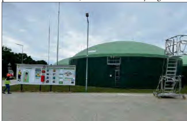
Czy odpady mogą stać się źródłem energii? Gogolińska biogazownia pokazuje, że tak.
