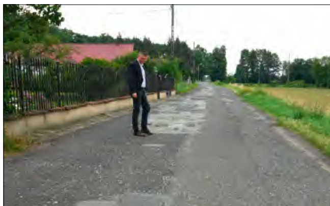
Na ul. Wygoda po wykonaniu sieci kanalizacyjnej, odtworzona zostanie nawierzchnia asfaltowa.
