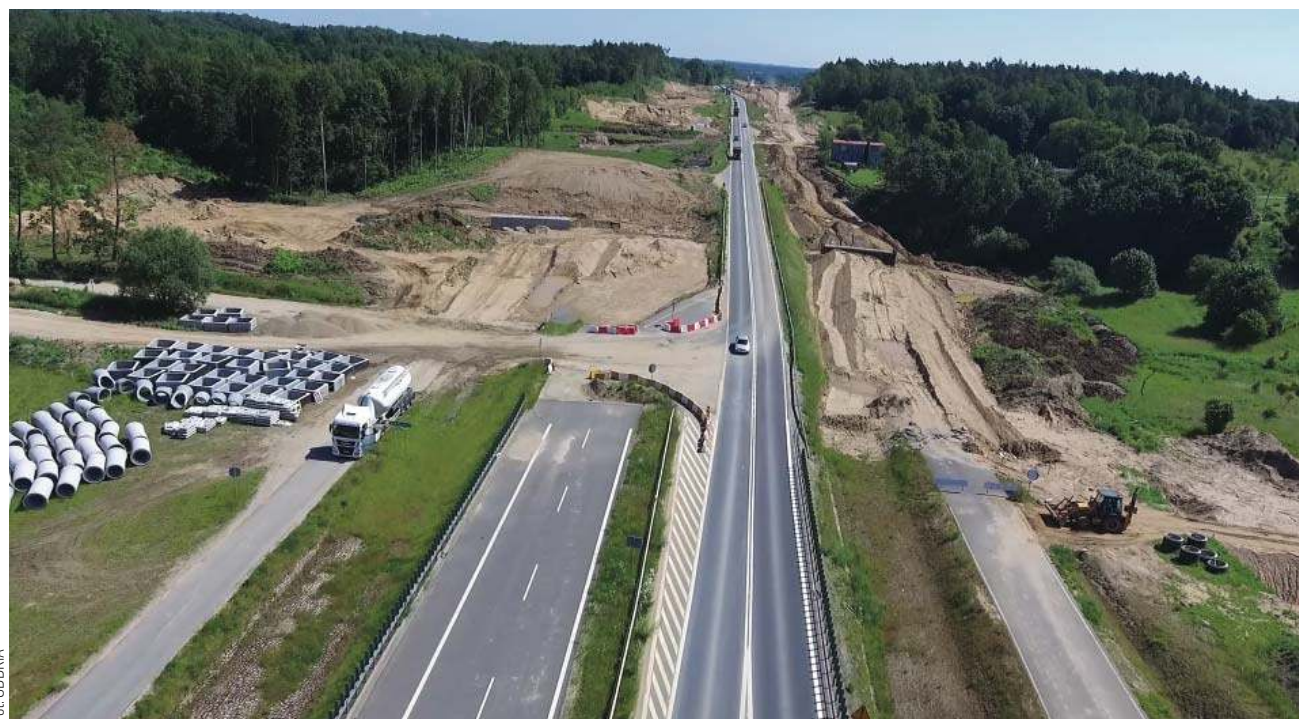
Obecnie trwa budowa S16 na odcinku Borki Wielkie – Mrągowo
