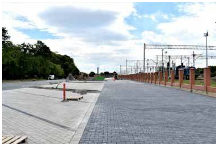
Układana jest nawierzchnia miejsc postojowych dla autobusów
