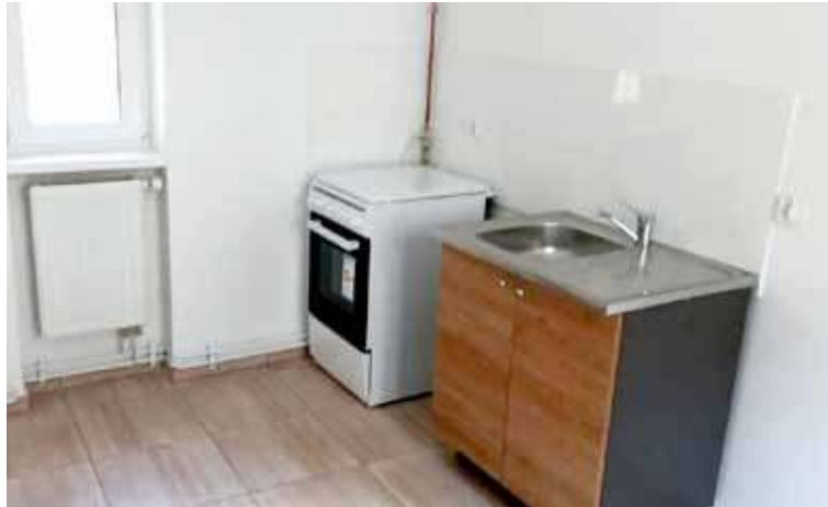
W mieszkaniach wykonano instalację centralnego ogrzewania
