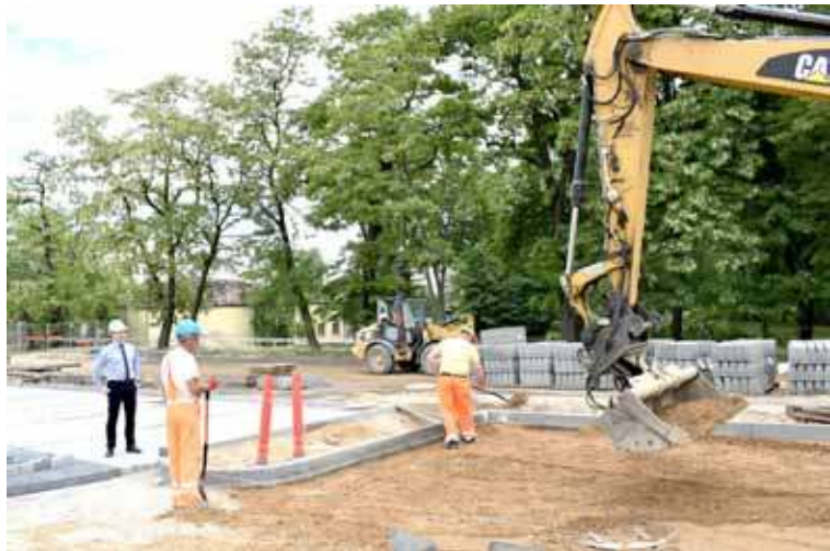
Od strony Barnima wykonawca układa krawężniki
