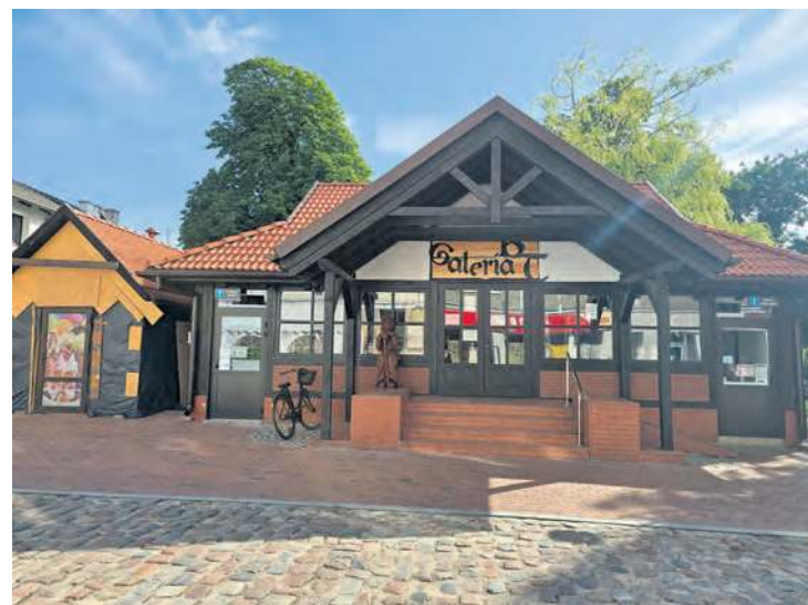
Na górę obiektu została przeniesiona Galeria BT.
