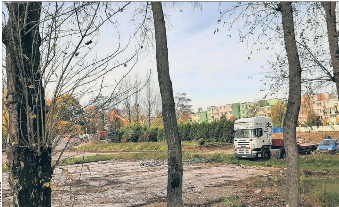
Trwa przygotowywanie placu budowy w miejscu, gdzie powstanie płocki aquapark
