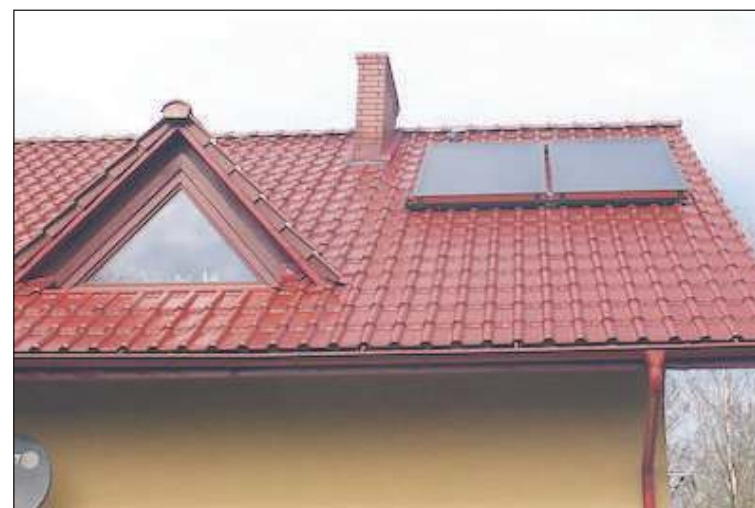
Najwięcej zamontowanych zostanie kolektorów słonecznych.
