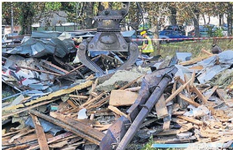
Budowa S74 coraz mocniej zmienia tę część Kielc
