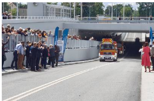
Nowy tunel to kolejna istotna modernizacja infrastrukturalna.
