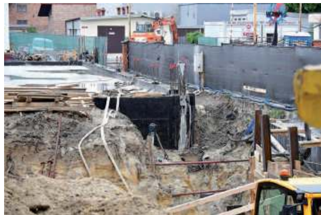
Budowa hali sportowej RCEZ w Biłgoraju
