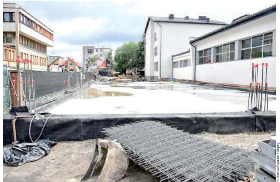
Budowa hali sportowej RCEZ w Biłgoraju
