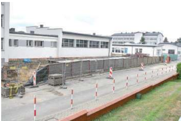
Budowa hali sportowej RCEZ w Biłgoraju
