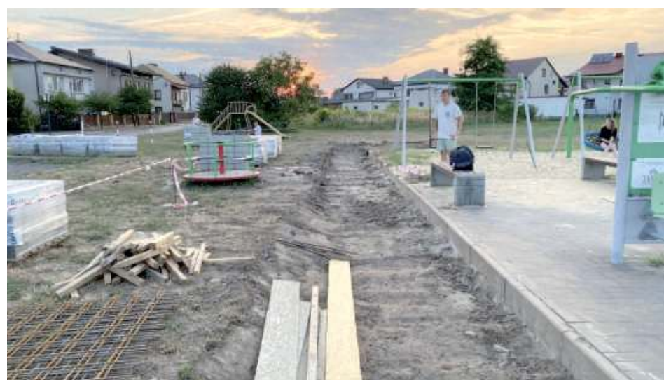
Rozpoczęła się budowa biłgorajskiej tężni solankowej
