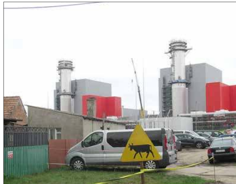
Prywatny dom przy bramie elektrowni gazowej i taki znak wyglądają szokująco
