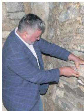
Dariusz Pożuczek, główny wykonawca przebudowy strzeleńskiego ratusza, podczas zamurowywania aktu erekcyjnego w ratuszowych piwnicach
