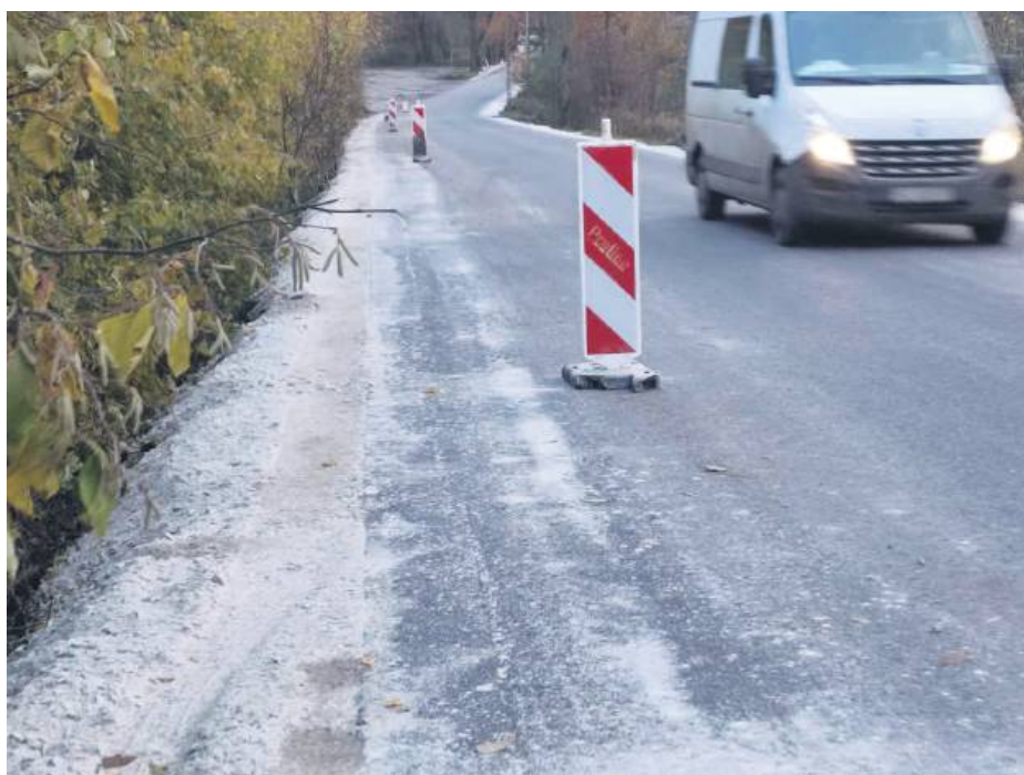
Tak obecnie wygląda remontowana ulica Piastowska
