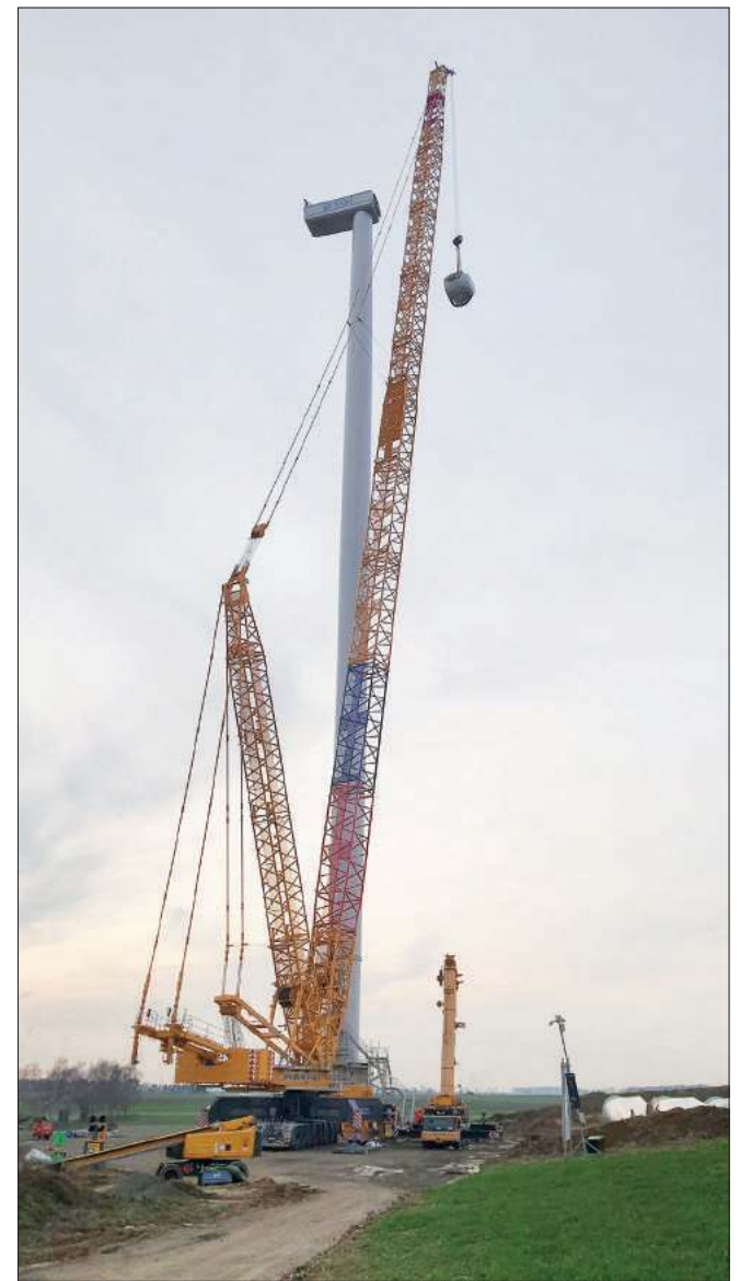
■ – Przewidujemy, że dalsze prace montażowe potrwać do czerwca – mówi Marek Matkowski, kierownik projektu budowlanego w VSB Energie Odnawialne Polska FOT. VSB (2)
