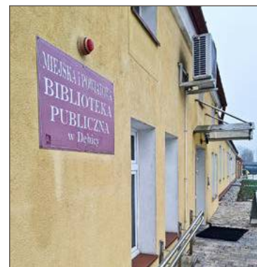
Budynek powstał pomiędzy 1881 a 1885 rokiem.
