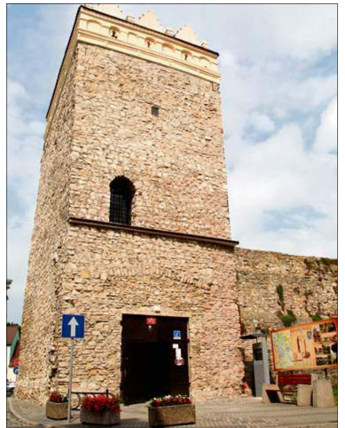
Zostaną wymienione drzwi wejściowe oraz drzwi prowadzące na taras widokowy na szczycie wieży.
