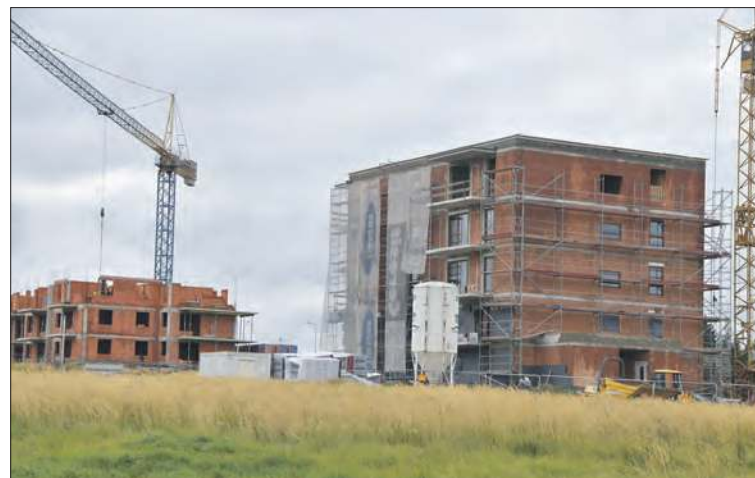
Budynki PTBS i SIM Opolie Południe
