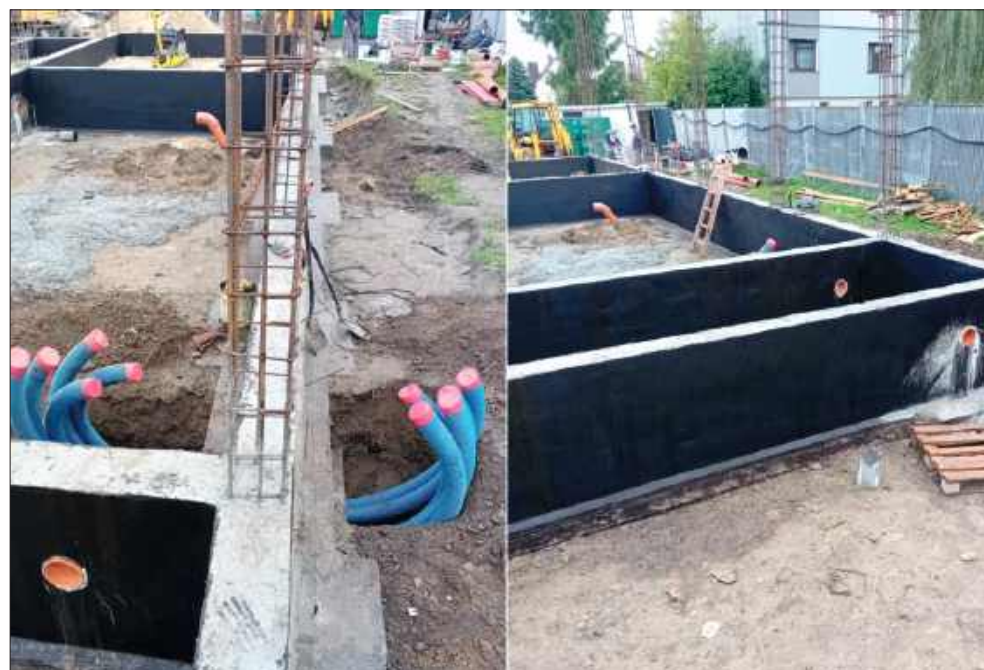
Tak obecnie wygląda plac budowy.
