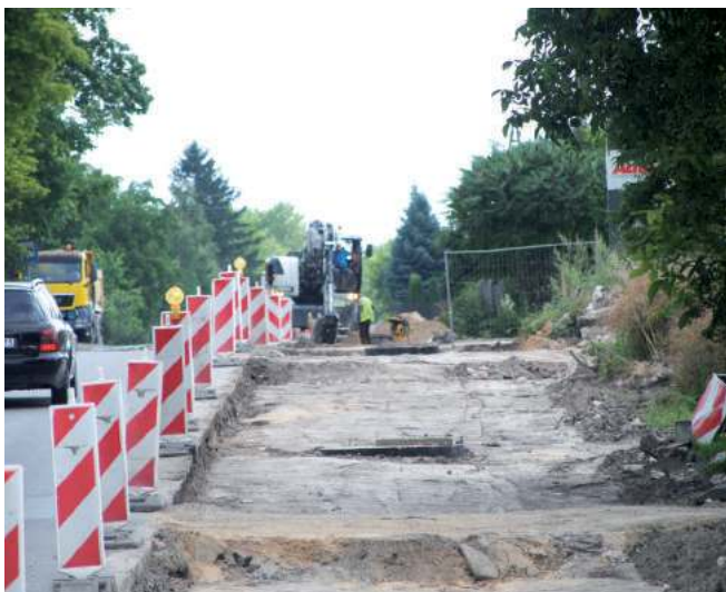
Wykonawca ułożył kostkę brukową na odcinku 335 m, na pozostałym 533 m wylany zostanie beton asfaltowy
