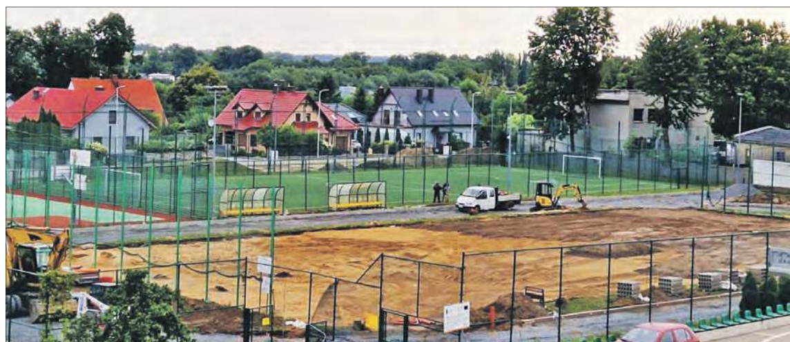
Trwa inwestycja na Kompleksie Sportowym przy Starostwie Powiatowym. Obecnie zakończył się etap utwardzenia pod tartanową bieżnię i przygotowujące się warstwy ziemne pod nową murawę trawiastą. Zakończenie prac planowane jest na drugą połowę listopada.
