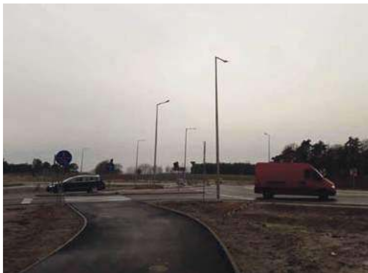
Obwodnica ciągle zamknięta, można tylko przejechać rondem
