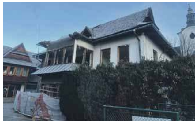
Ruszyła rozbiórka starej poczty i OPS...
