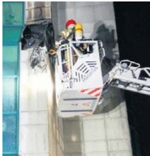
Pożar elewacji Narodowego Banku Polskiego
