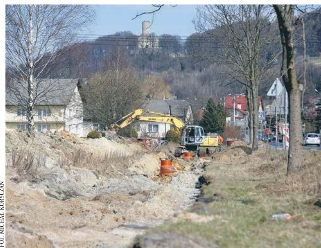
Podczas budowy kanalizacji Babic w rejonie ul. Zakopiańskiej
