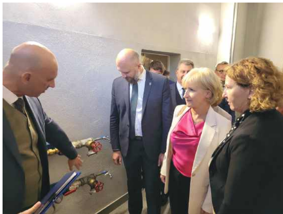
■ Dyrektor szpitala Michał Rupik pokazuje ujęcie wody w podziemiach gmachu
