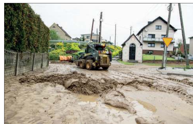
Zwały błota zalegające na ulicach Owsiszcza są systematycznie usuwane
