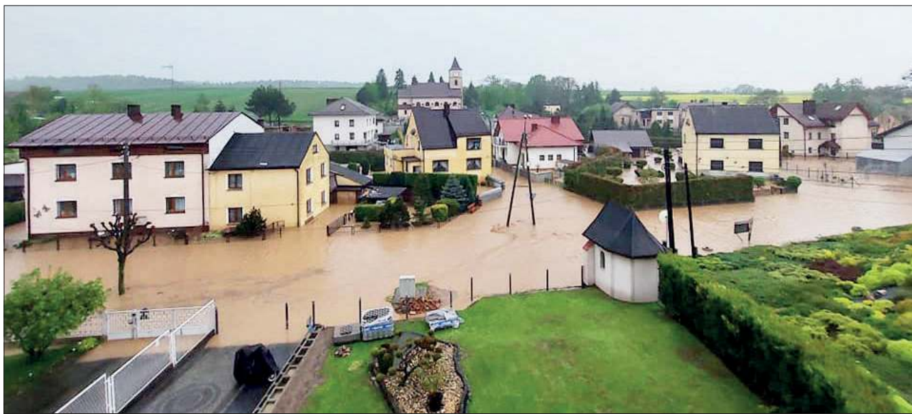
Pod wodą znalazło się m.in. sołectwo Owsiszczyc w gminie Krzyżanowice
