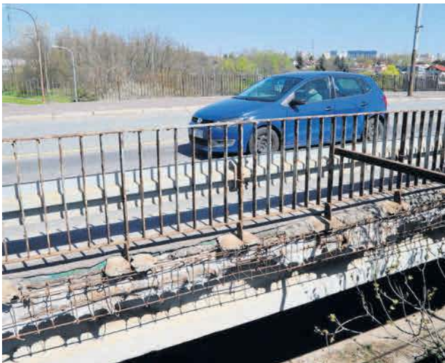
Wiadukt na ul. Przybyszewskiego będzie przebudowany. Prace mają się zakończyć do 2023 r.
