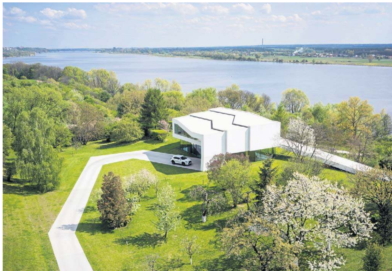
Dom Po Drodze autorstwa Roberta Koniecznego został zbudowany dla prywatnego inwestora nad Wisłą, w pobliżu Płocka. W 2019 roku otrzymał German Design Award Special
