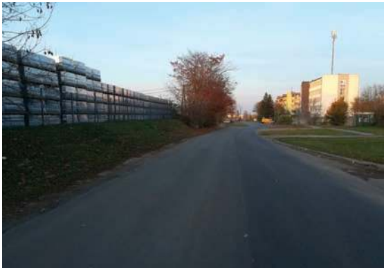
Dodatkowe prace remontowe obejmują ulicę: Dożynkową, Nadstawną, Targową, Skrzynicką i Grenadierów
