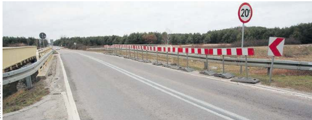
Na Jodłowce na powstanie nowa przeprawa mostowa
