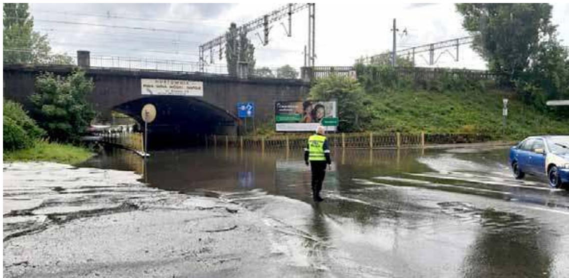
Za sprawą wykonania kanalizacji deszczowej woda gromadzona przy wiadukcie ma być odprowadzana do rzeki Iny
