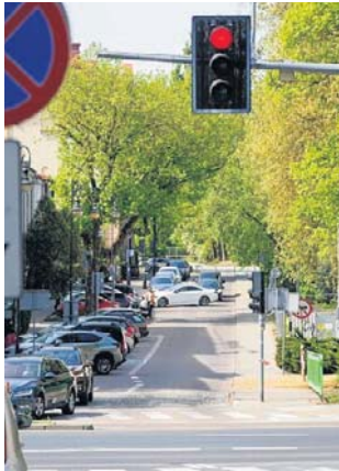
Ulica Elektryczna będzie przebudowana
