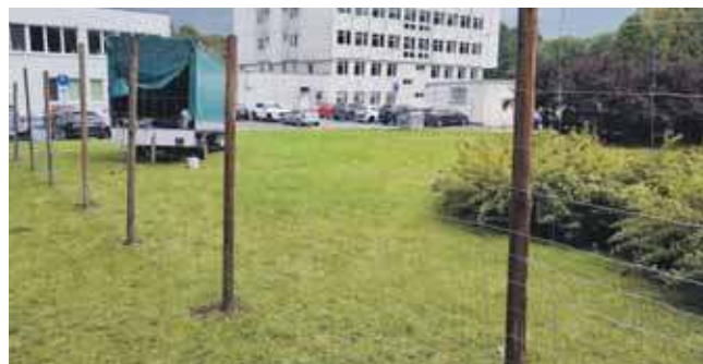
W ubiegłym tygodniu ruszyła budowa Eco Parku
