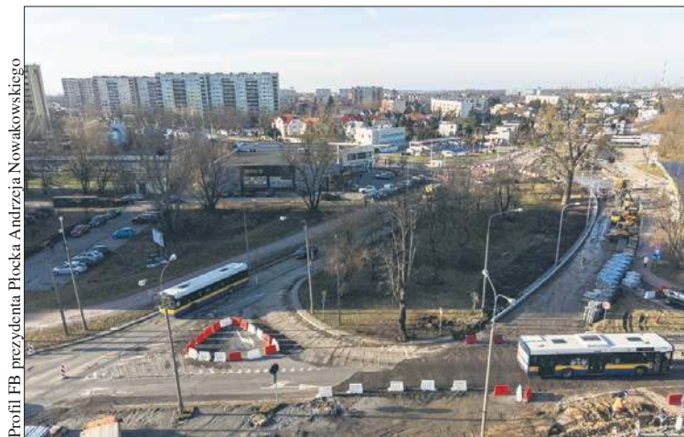
Trwa przebudowa ul. Chopina na wysokości dworca autobusowego
