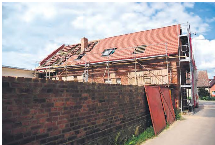
Mur od strony ul. Cmentarnej zostanie rozebrany.
