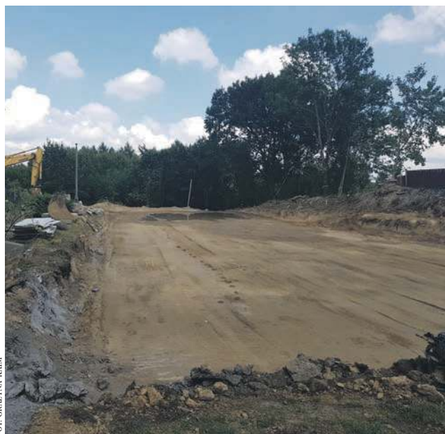
Teren budowy Muzeum Pożarnictwa w Alwerni. Jesienią przyszłego roku powinniśmy już oglądać ukończony budynek
