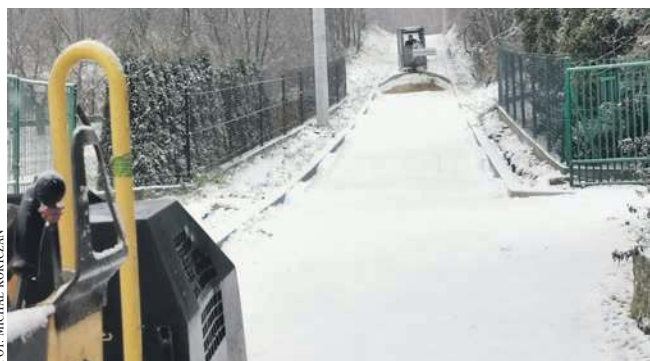
Trwa przebudowa ul. Zamkowej w Babicach
