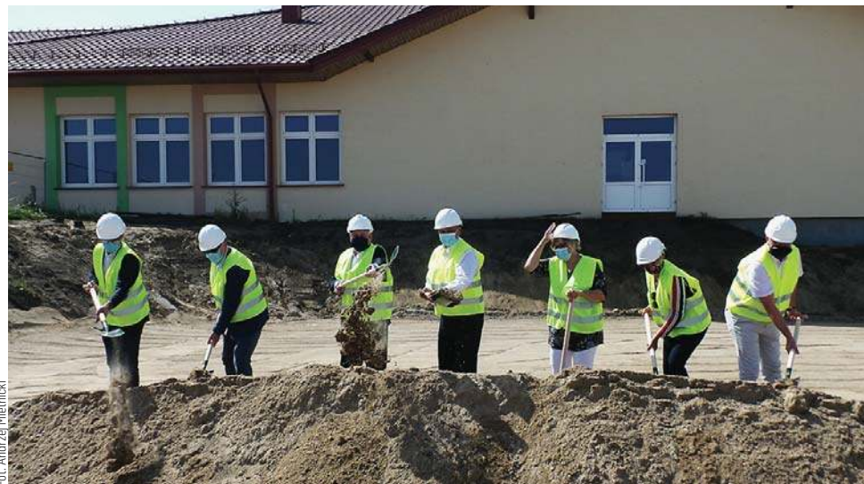
Wbicie łopaty pod rozbudowę Centrum Edukacyjno-Rehabilitacyjno-Zawodowego w Biskupcu
