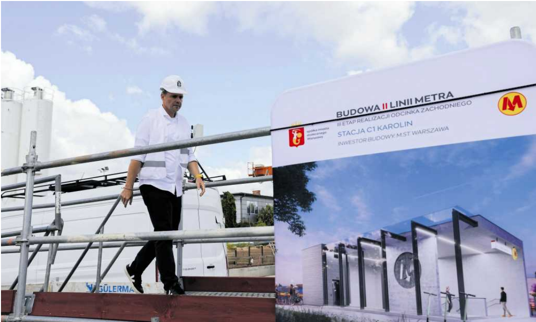
• Prezydent Warszawy na budowie ostatniego odcinka II linii metra na Bemowie
