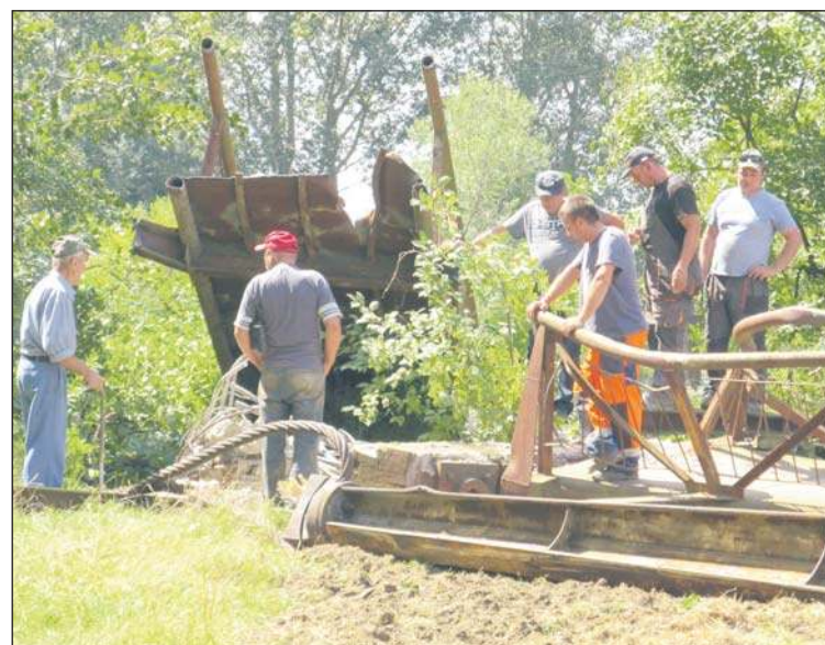
Kładka nad Wisłoką zdemontowana została w czwartek 4 sierpnia.
