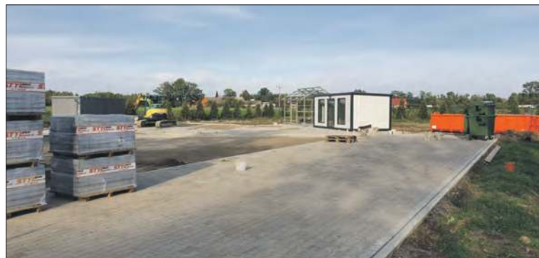
Modernizacja i rozbudowa PSZOK-u w Korfantowie
