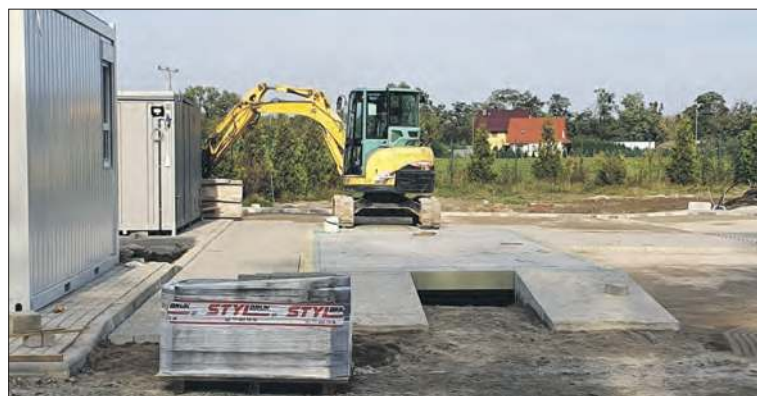
Prace przy budowie PSZOK-u mają potrwać do początku grudnia
