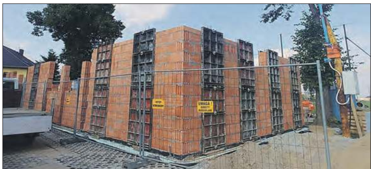
Prace przy budowie obiektu szatni, stan na koniec września
