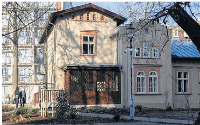
W Kossakówce trwają ostatnie prace kosmetyczne
